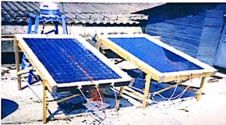
Gambar : Kolektor surya pemanas air tenaga surya, dengan menggunakan Honeycomb dan tidak menggunakan Honeycomb
